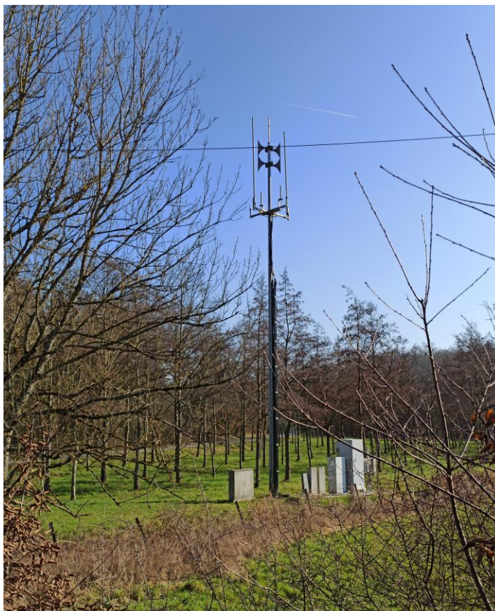
Figure 1 : Vue du site
