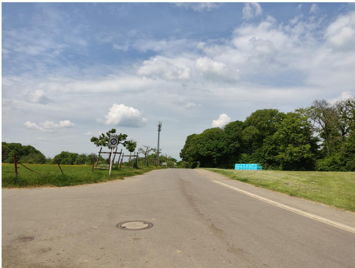
Figure 2 : Vue des alentours des antennes
