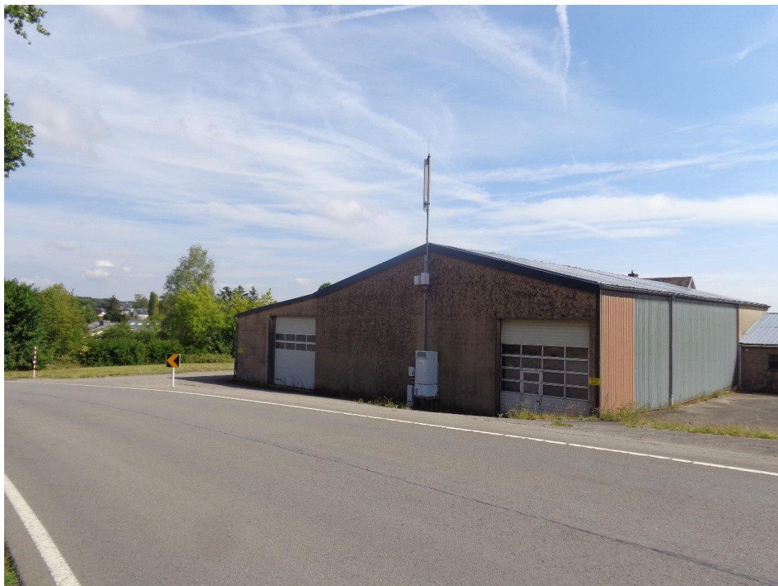
Figure 1 : Vue du site
