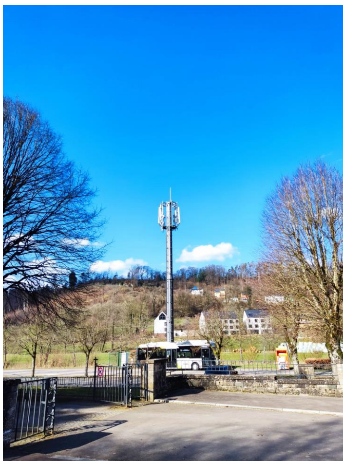
Figure 1 : Vue du site
