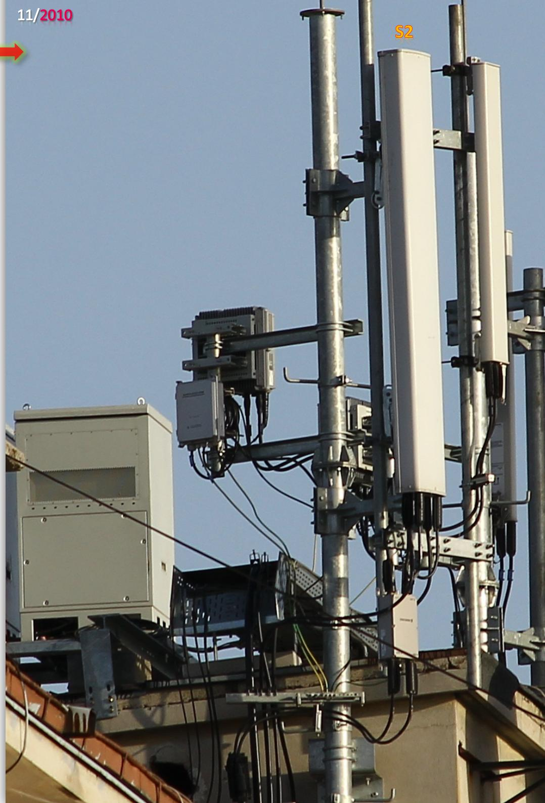
Ca si RBS-uri avem foarte probabil două Ericsson 2106 montate sus pe terasa, însă undeva mai jos fata de antene (care sunt supraînaltate pe etaj superior), pe un fel de terasa inferioară – aşa că nu se văd mai deloc în poze (cea alăturată fiind facută tocmai de la Izvor, de la peste 300m distanță)... Vezi totuși ghidul de feederi cum coboară pâna acolo.
