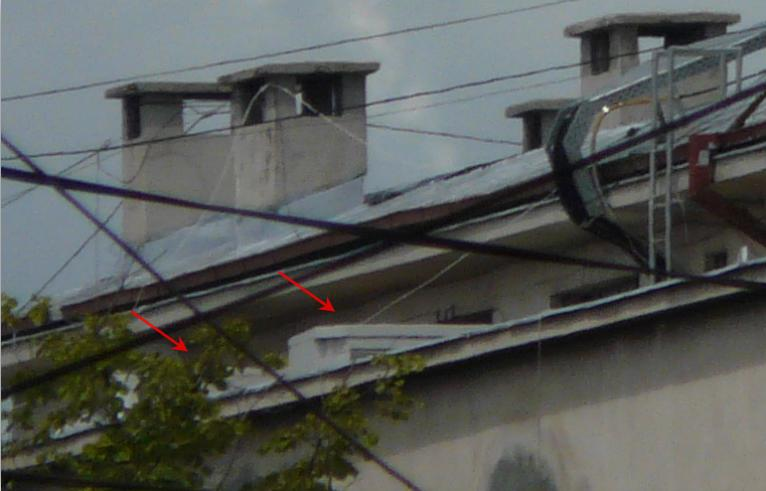
Vad că aparent peste tot se instalează ambele cabinete. Am găsit pe Net că este vorba de modelul de *BASE BAND UNIT* (BBU) ZXWR BBUB, iar pentru *REMOTE RADIO UNIT* (RRU) este vorba de ZXWR R8840 (cel puțin asta s-a montat pe NodeB-urile Zapp).
