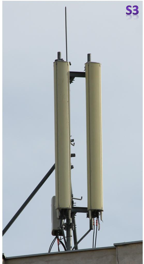
Aici ambele antene sunt utilizate, însa cu aceasi idee generala ca pe **S1** – unul din jumperii GSM a fost sectionat, pentru a nu mai ramâne per total decât cu 2 jumperi pentru partea GSM :
